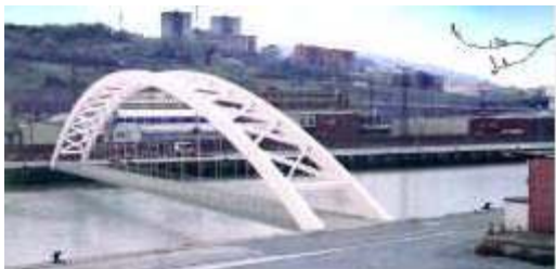
Ilustración 9. Simulación de la colocación del Arco. Fuente: El correo
